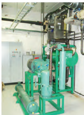
Hybridvarmepumpe med skrukompressor til bygningsoppvarming
