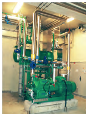
Eksempel på hybridvarmepumpe for leveranse av varme på ca. 80-95 oC stempelkompressor
